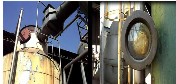
**Figura 3.** Separador de arrastres horizontal y mirilla de observación de meladura separada.
